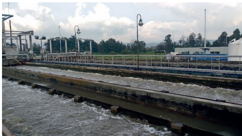
Figura 1. Planta de tratamiento de agua residual.
