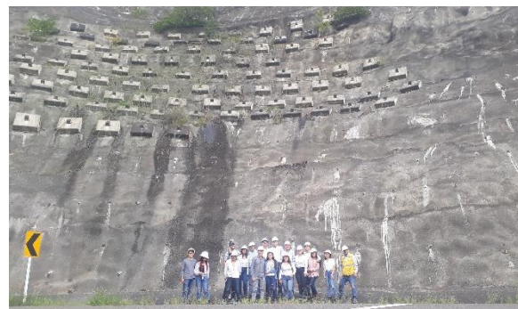
b) Reconocimiento de estructuras de contención
