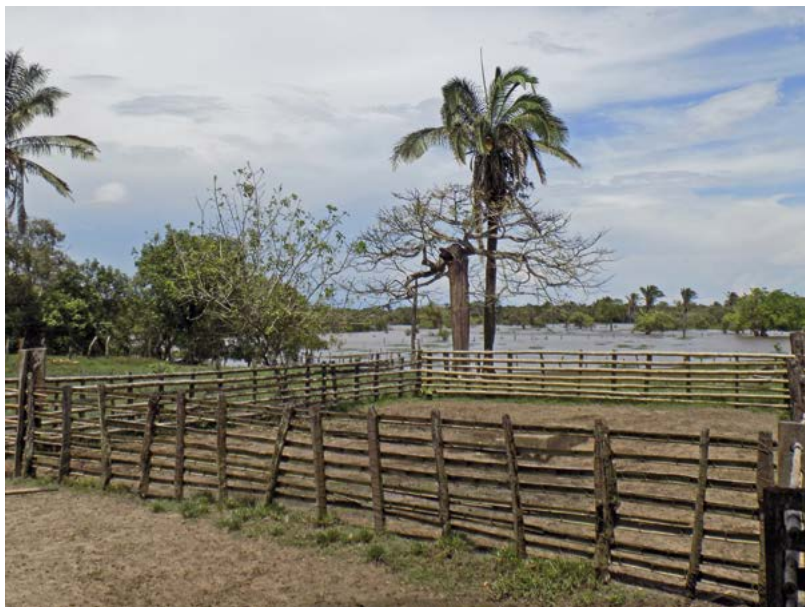
Figura 2. Corral de construcción tradicional en guafa o guadua Fuente: archivo personal del autor
