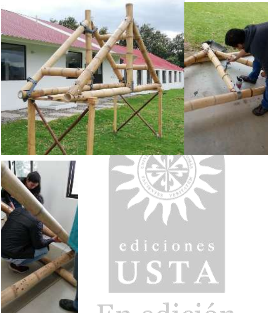
Figura 2 Proceso de montaje de la cercha.
